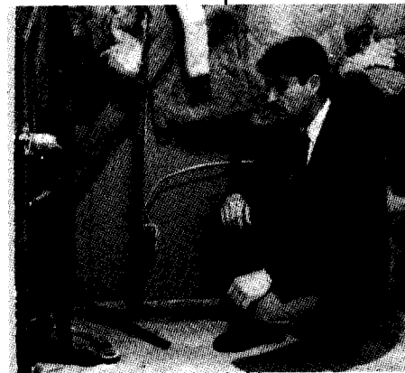
CONTROLANDO: El Director de Servicios Técnicos Tom Pohle inspecciona la renovación de un baño en una unidad de alquiler de la Autoridad de Viviendas. Al baño se le está poniendo nuevas cañerías y acceso para personas incapacitadas.
